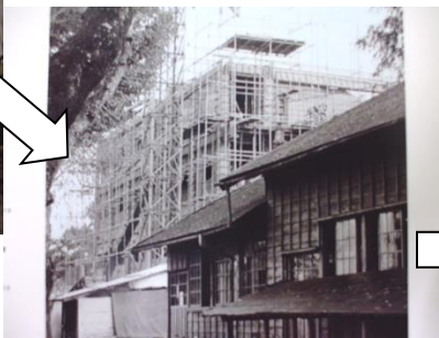
新校舎建設中 (昭和40年ごろ) (木造の旧校舎と鉄筋の新校舎の 両方が見える)
