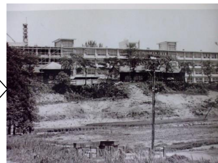
鉄筋コンクリートの新校舎完成 (昭和41年)
